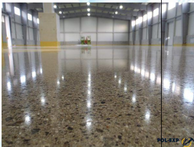
3-расм. Мрамар увоқларидан бетонли полларни қуриш
